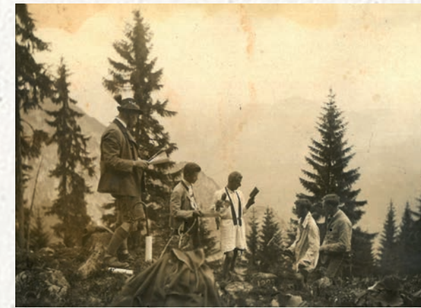
Spatenstich und Firstbier 1923
